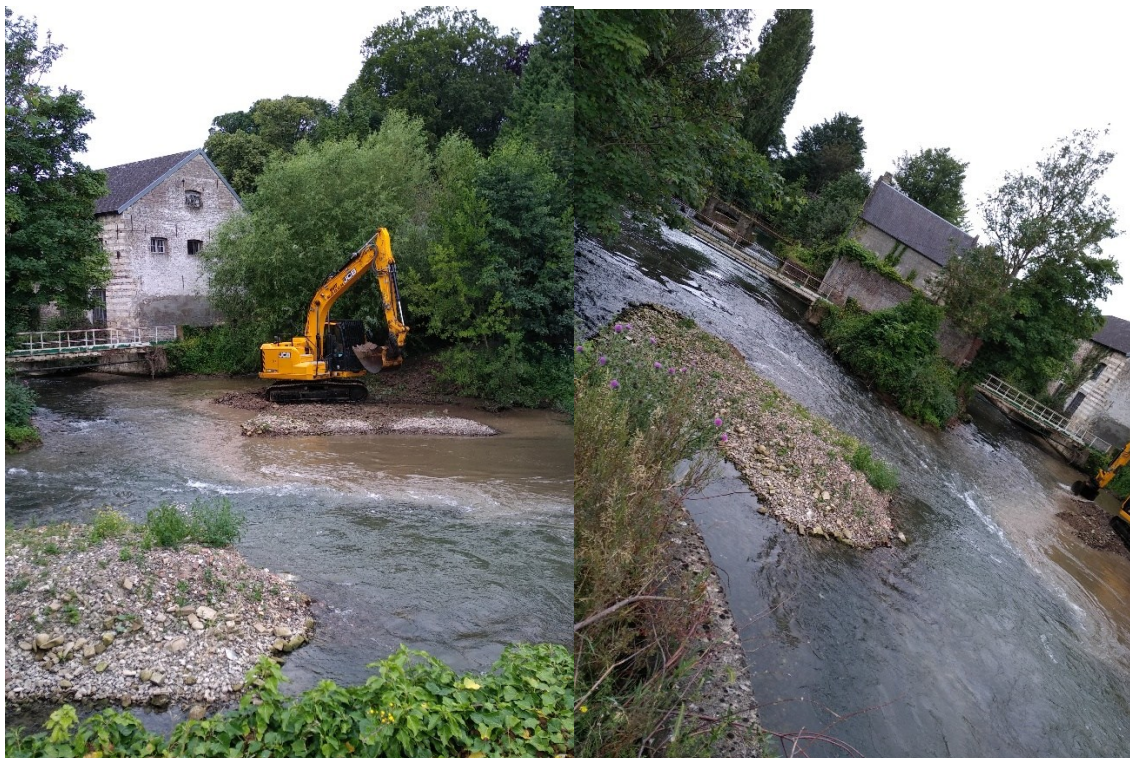
Figure 4-2 Photos de l'opération de curage de la zone d'atterrissement en aval du Moulin Marin (8 juillet 2024, source SmageAa)
