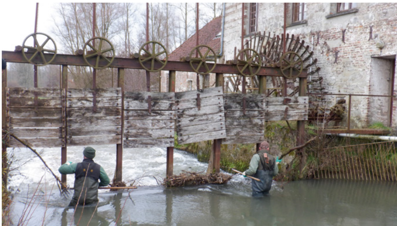
Photo 7 : Entretien d'un ouvrage
