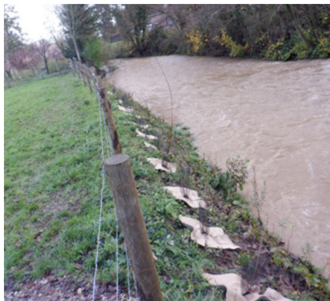
Photo 4 : Travaux de restauration des berges
