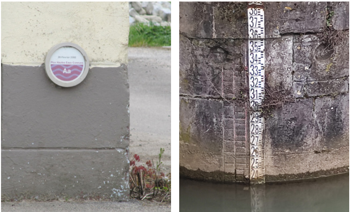
Photo 12 : Repère de crue et échelle limnimétrique
