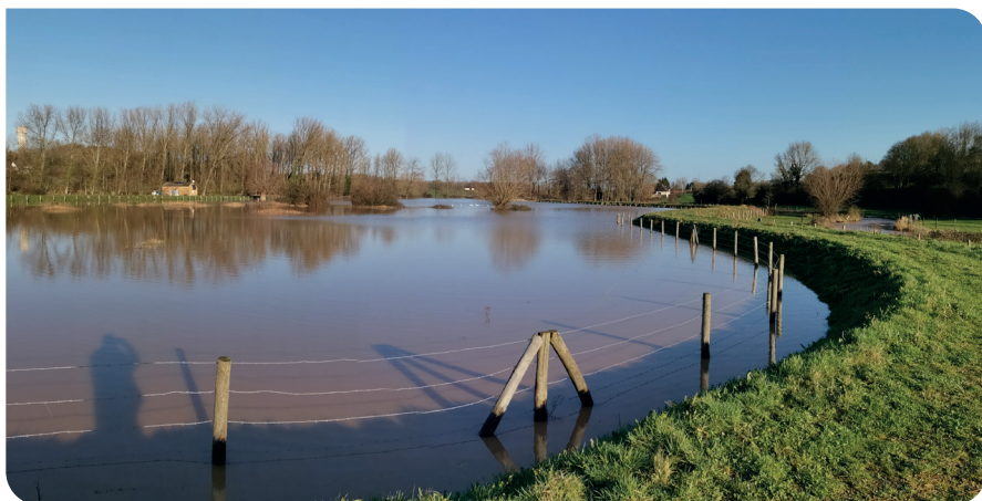
Mobilisation du Champ d'Inondation Contrôlé n°1 à Saint-Martin d'Hardinghem
