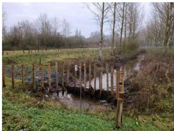
Exemple de ZEC avec un dispositif anti-embâcles
