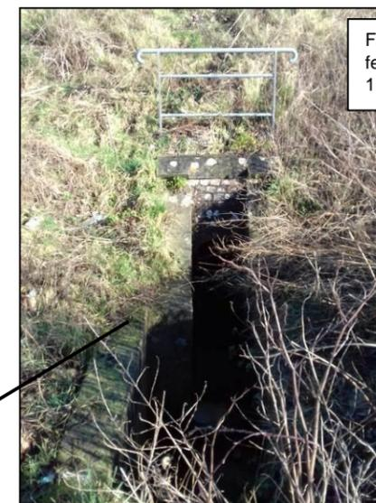
Franchissement sous la voie ferrée, environ 0m60 de largeur et 1m50 de hauteur.
