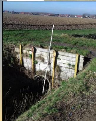
Redent avec busage de 1000mm de diamètre. Stockage dans le fossé amont.
