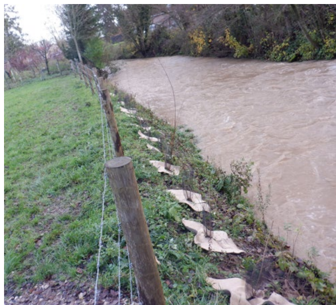
Photo 4 : Travaux de restauration des berges
