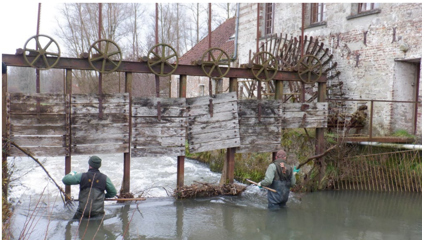
Photo 7 : Entretien d'un ouvrage
