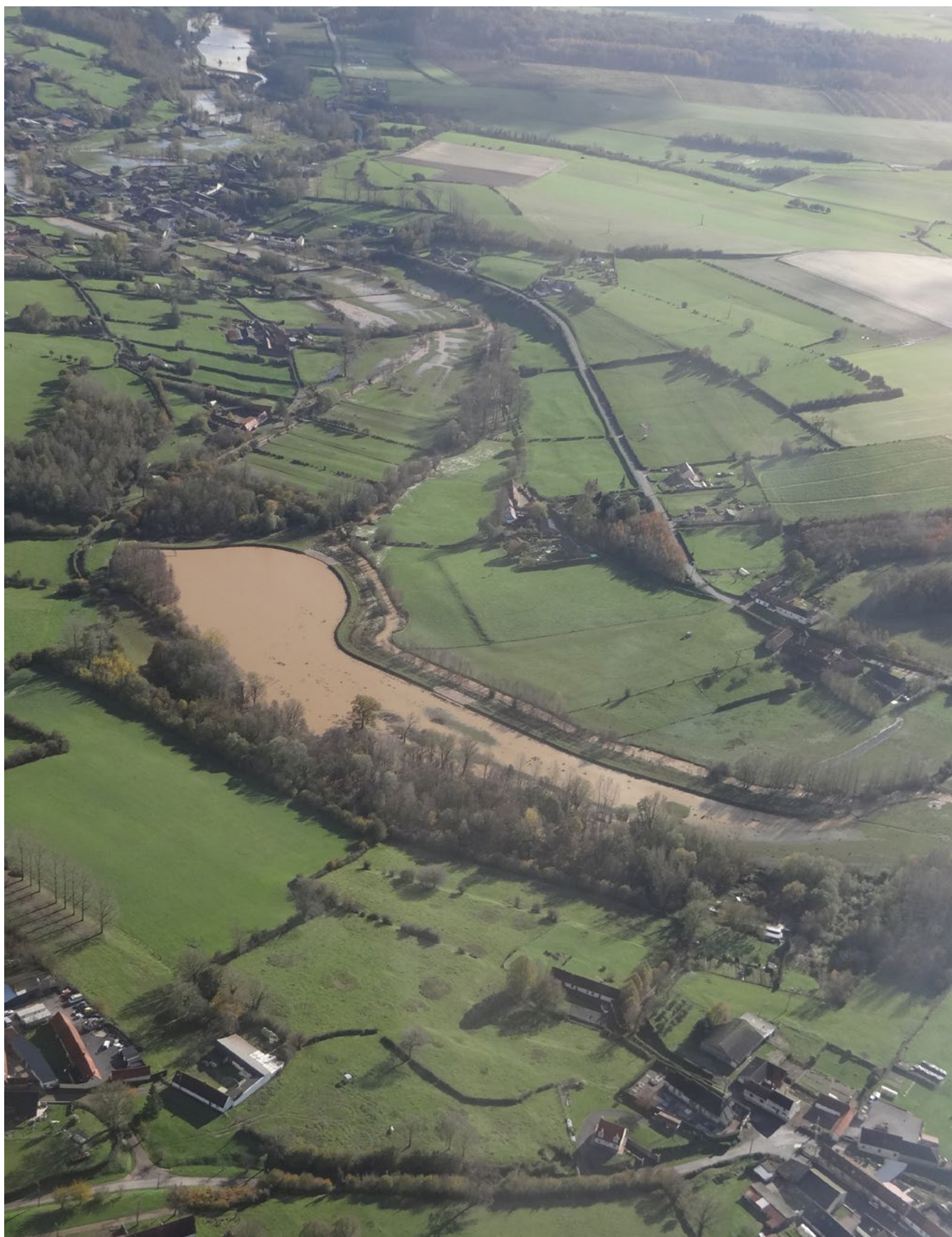
Photo 13 : Champ d'Inondation contrôlée en crue
