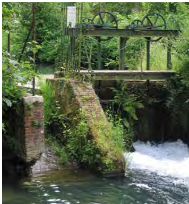
Photo 7 : Exemple d'un barrage sur la rivière Aa.
