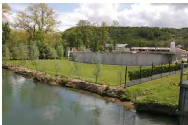
Photo 8 : La station d'épuration de Wizernes.
