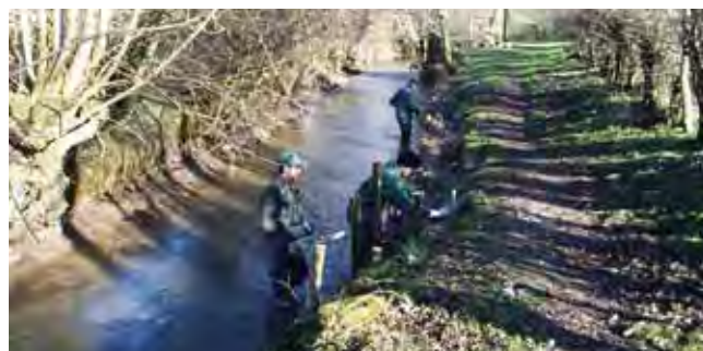
Photo 10 : Restauration d'une berge à l'aide d'une technique issue du génie végétal par l'équipe d'entretien de l'Aa et ses affluents.
