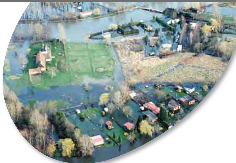
Photo 12 : Vue aérienne de l'inondation de février / mars 2002.
