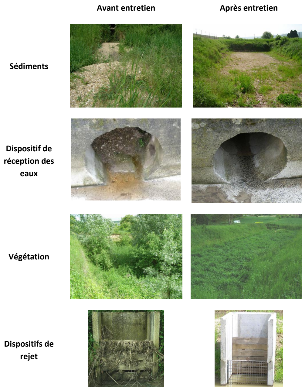
Figure 13 : Entretien des ouvrages d'écroulement
