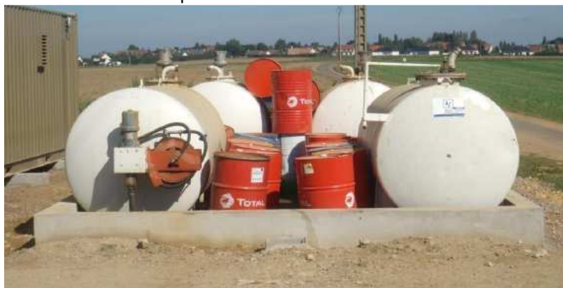
Figure 71 : Exemple de stockage des produits sur une aire étanche
