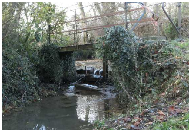
Figure 43 : Exemple d'ouvrage complexe (ancienne passerelle effondrée formant un passage à gué)
