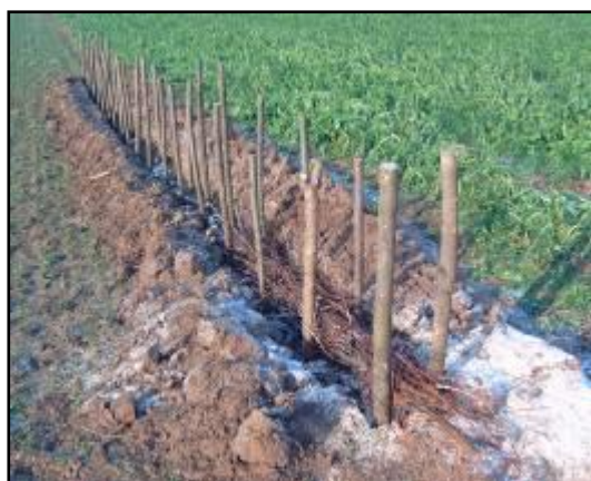
Préparation de la tranchée
