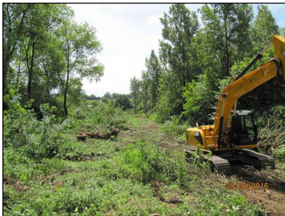
Travaux du CIC n°4 – déboisement (été 2015)
