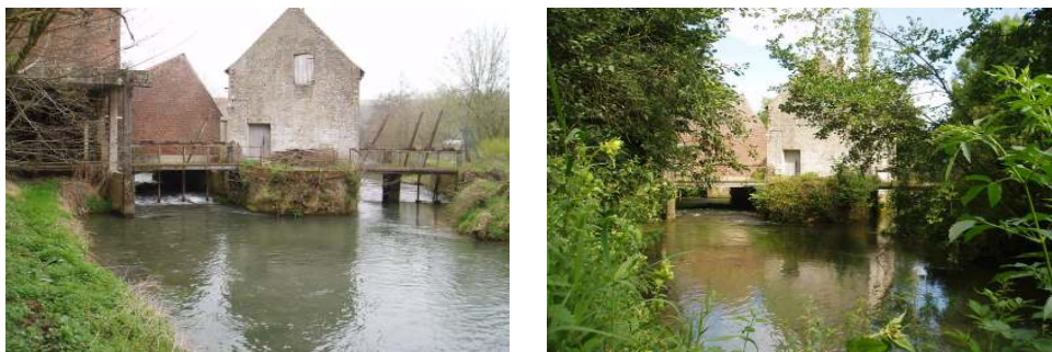
Ouvrage avant et après travaux
