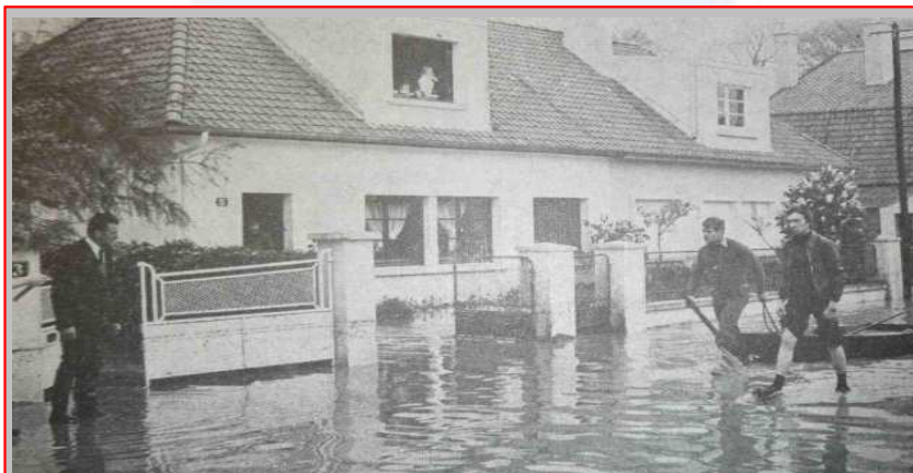
Samedi matin, la rue A André, à Longuenesse est encore inondée. Les habitants sont ravitaillés par une barque. On peut voir sur le mur de clôture la hauteur atteinte par la crue.
