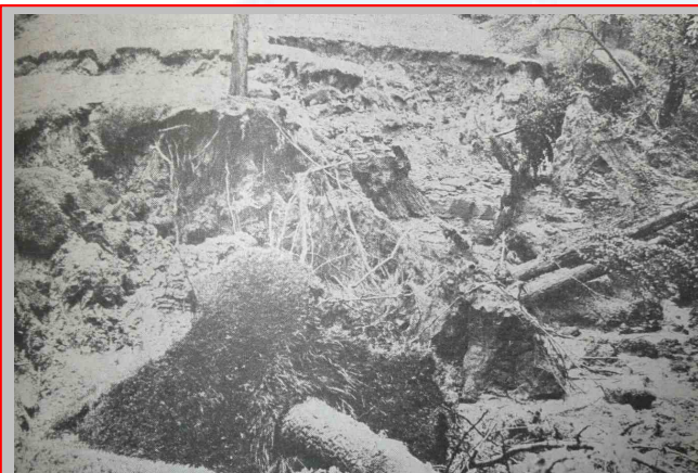
Au débouché du torrent dans le fossé des remparts, sur le terrain des Glacis, une grande crevasse a été creusée et des arbres abattus.
