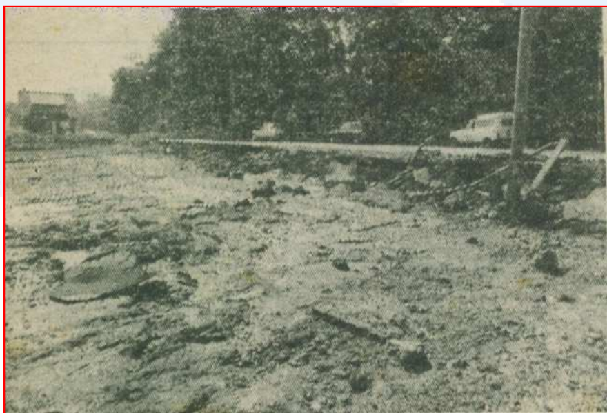
Le bitume des routes a été emporté par le torrent
