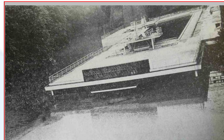
La piscine de Saint-Omer à l'eau ! Un spectacle tout à fait étonnant, mais qui coûtera cher en réparation des installations noyées, sous près de 2 mètres d'eau limoneuse.
