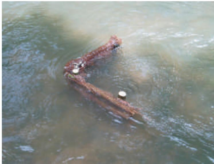
L'ensemble des aménagements seront réalisés avec des matériaux en bois, la pierre n'étant pas adaptée à nos types de cours d'eau, étant donné que nous n'avons pas d'affleurement rocheux. Tous les ouvrages n'entraîneront pas de différence de niveaux d'eau de plus de 20 cm. Ils seront mis en place avec un écoulement noyé (l'eau passant par dessus l'ouvrage) en fin de printemps afin d'éviter des changements d'orientation du flux hydraulique pouvant entraîner une dérive du cours d'eau.
